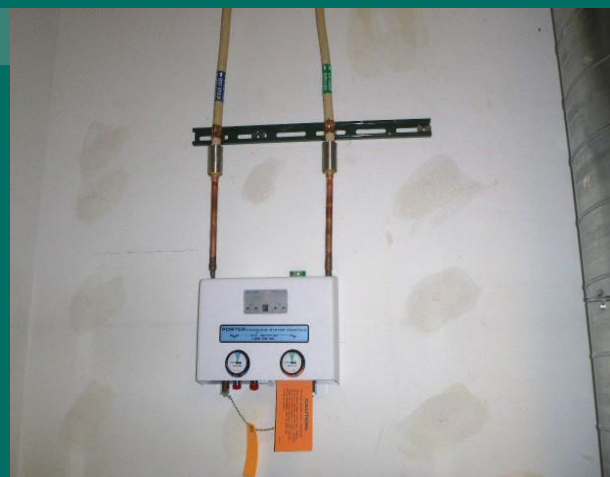
Anschluss des MediTrac® CMT-Systems an den Verteiler einer Zahnklinik
